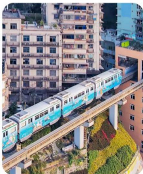
李子坝轻轨穿楼 列车从居民楼呼啸而过
