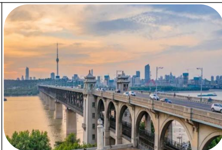
武汉长江大桥
